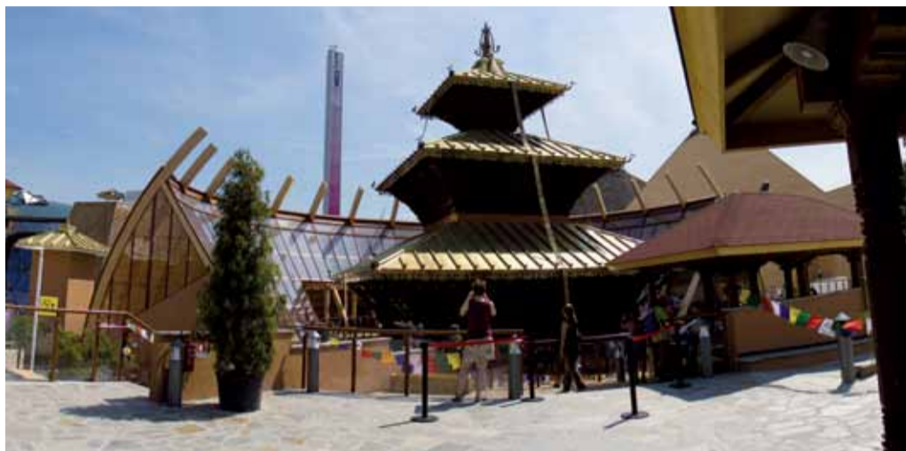
Il padiglione del Nepal all'Expo. La copertura radio dell'evento è garantita da sei torri per telecomunicazioni realizzate da Calzavara. In basso, l'ingresso degli uffici
