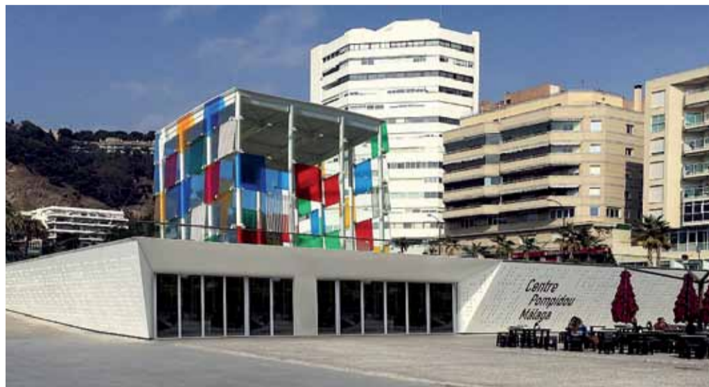
Il Centre Pompidou di Malaga, la versione pop-up recentemente inaugurata del noto museo parigino, costruita con 100 lastre i.light
