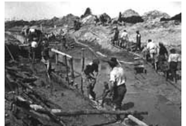
Lavori di sistemazione canale
