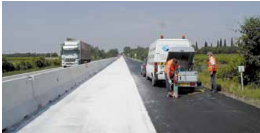
Verifica in corso d'opera degli spessori reali di conglomerato bituminoso (raccordo autostadale Villesse-Go)
