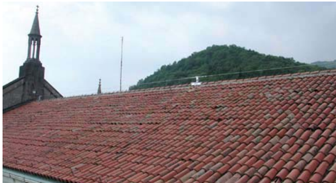
La "Linea vita fissa" della Seiduesei srl somiglia a una ferrata sulla quale i vari professionisti, come i fumisti o lattonieri, possono agganciare la propria imbragatura. Sotto lo staff di Seiduesei
