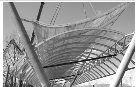
La copertura delle tribune dello stadio di Treppo Grande
