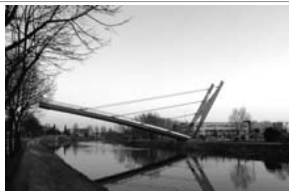
Ponte mobile di lunghezza pari a 48 m per il superamento del fiume Sile a Jesolo (Ve)
