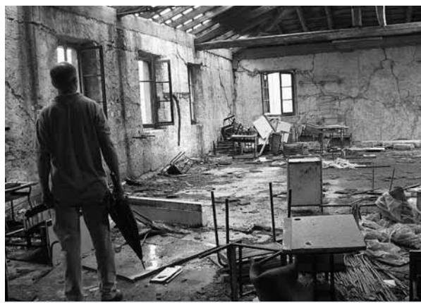
Sopra e nel riquadro in alto alcune case abbandonate a Venzone e Moggio
